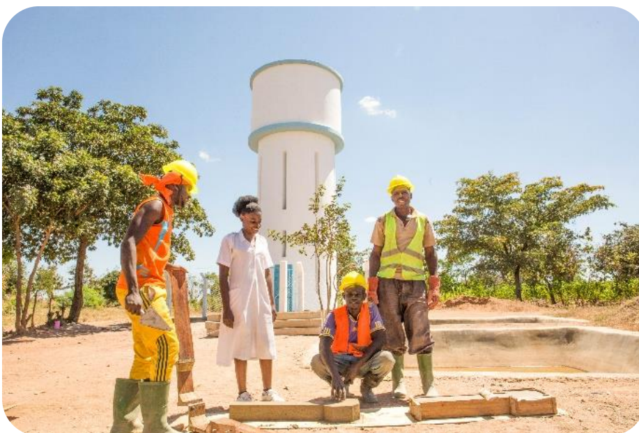
L'infirmière Grace Nabenga Lufu discutant avec les maçons apportant les finitions au nouveau réservoir d'eau qui fournira de l'eau courante à l'infirmierie de Kakora à tout moment. District de Nyanghwale, Tanzanie.
